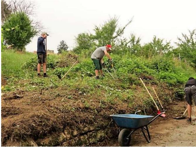
Zu Beginn der Arbeiten musste die Mauerkrone von den überwuchernden Wildpflanzen (insbesondere blutroter Hartriegel, Efeu und Schachtelhalm) gesäubert werden. Anschließend wurde die Tragfähigkeit der Mauer geprüft.
