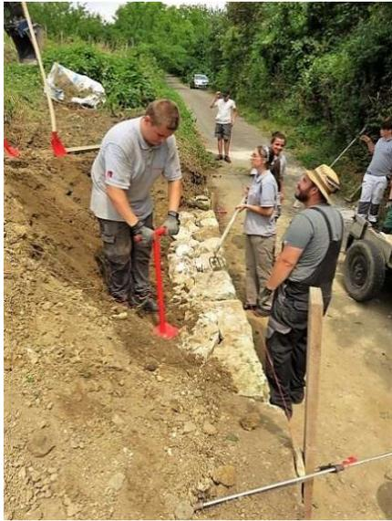
Nach dem Abbau erfolgte natürlich der Aufbau einer neuen Stützmauer; vorhandene Stoß- und Lagerfugen wurden durch Steinkeile ergänzt. Die für eine Trockenmauer üblichen Hohlräume zwischen den Steinblöcken werden später beliebte Rückzugsgebiete für Reptilien und Insekten bieten.
